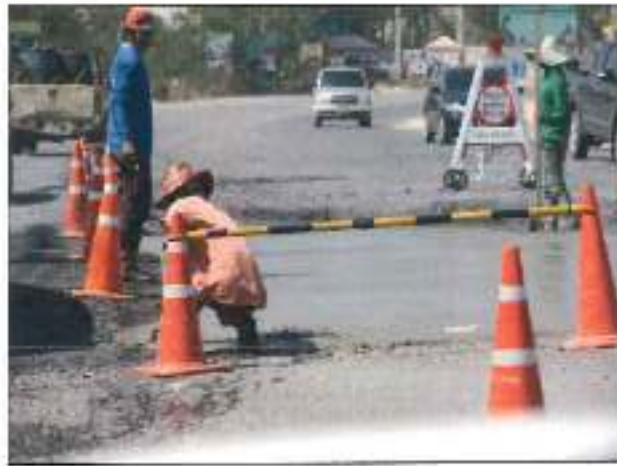
การซ่อมแซม ถนนบริเวณใกล้กับจุดตรวจวัด
