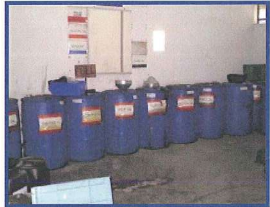
(ฉ) ถังรวบรวมน้ำมันหล่อลื่นที่ใช้แล้วขนาด 200 ลิตร
