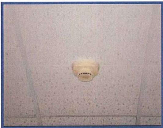
(ด) อุปกรณ์ตรวจจับควันและอุปกรณ์ตรวจจับความร้อน
